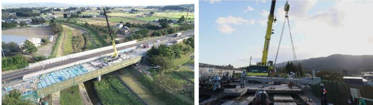
東北道 滝名川橋床版取替工事
